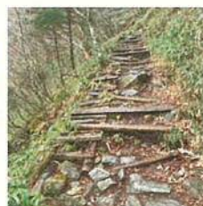
D:斜面沿いの悪路
