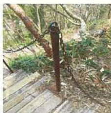
C:固定されていない手摺 (複数箇所あり)
