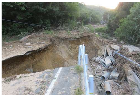
平成30年7月豪雨災害 尾道
