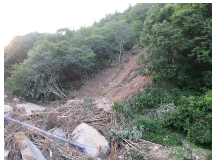
平成30年7月豪雨災害 尾道
