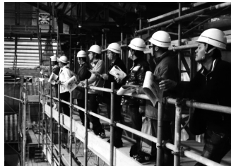
平成の大修繕を見学。スケールの大きさに驚かされた。
