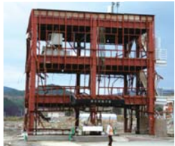
▲津波によって損壊した防災対策庁舎
